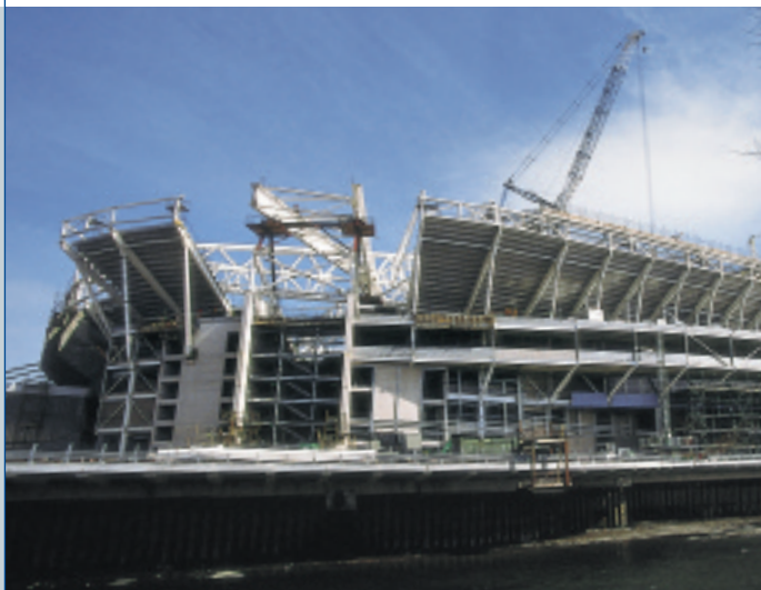
Окружающие условия для стадиона, находящегося в городской черте, согласно стандарту ISO 12944 должны классифицироваться как C3.
